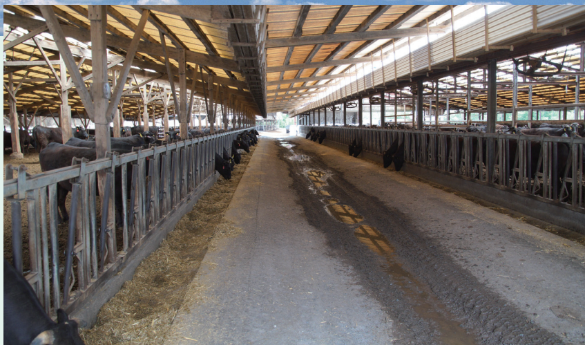
繁殖牛舎。妊娠済みの牛たちが1群約300頭の巨大フリーバーンで過ごしている。飼料は繁殖用のTMRのみ
